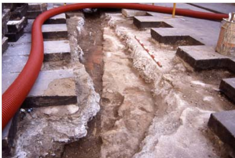
5. Restes del mur UE 8 (tram 1)
