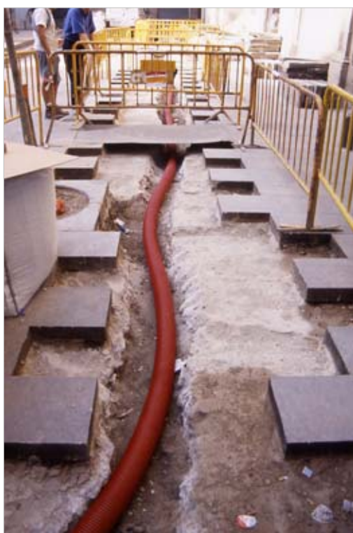
4. Treballs de col·locació de tubs (tram 1)
