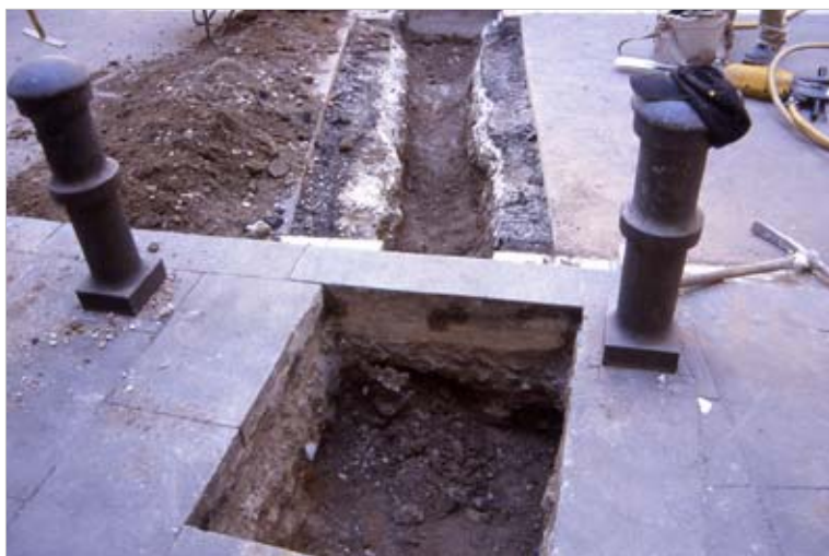
3. Rasa que creua el carrer Avinyó (tram 3)
