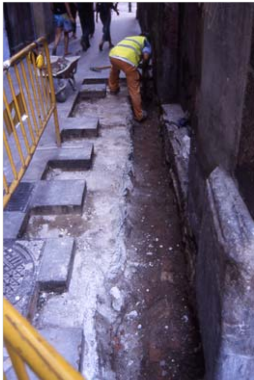
1. Treballs d'excavació del tram 2 (carrer N' Arai)
